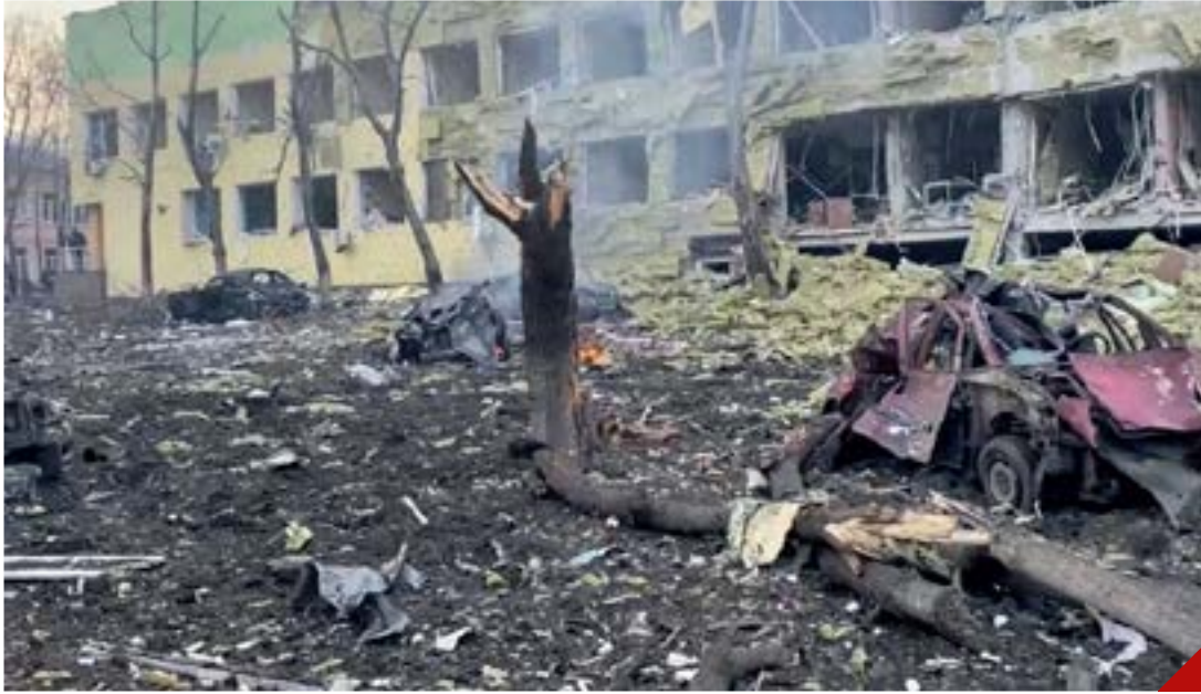
➤ Das Gebäude der zerstörten Geburtsklinik Nr. 2 in Mariupol.
